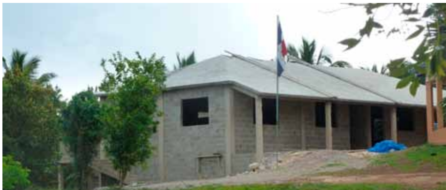
Edifice – Vue de l'entrée du terrain - février 2011
